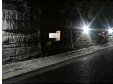
Instalación en túneles
